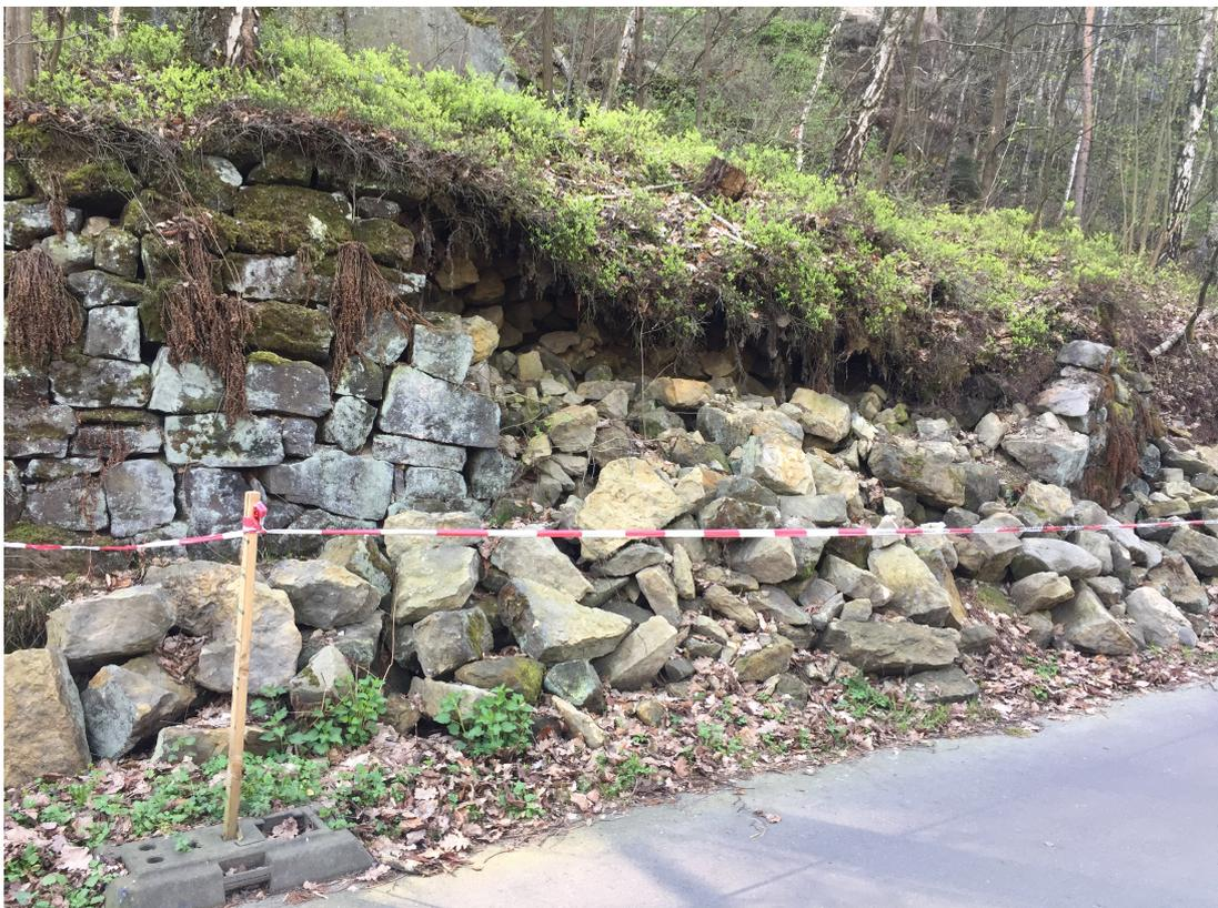
**Abb. 4.9:** Zerstörte Mauer im Bereich von Gans 11.
